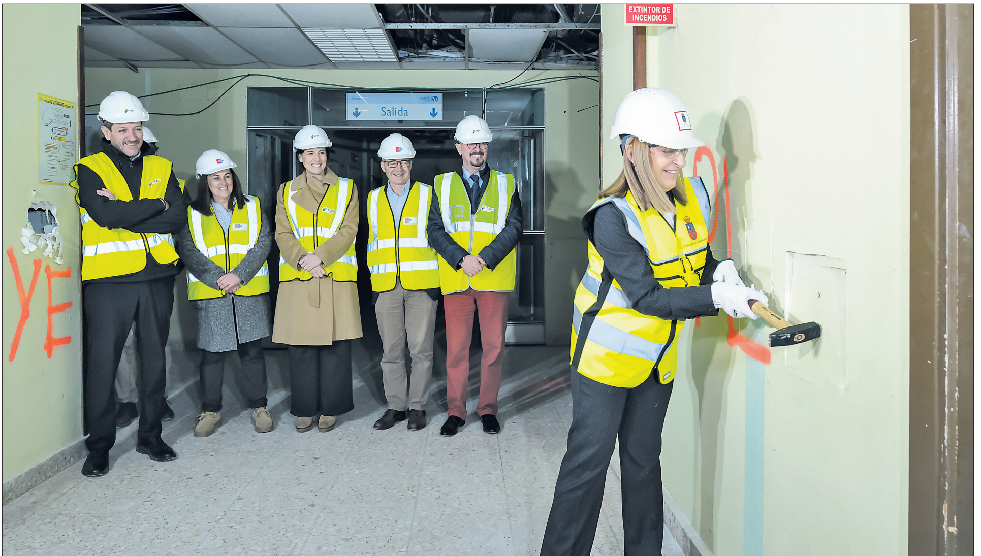
La presidenta regional, María José Sáenz de Buruaga, da el martillazo que simboliza el inicio de las obras de desmontaje de la Residencia Cantabria. / RAÚL LUCIO
