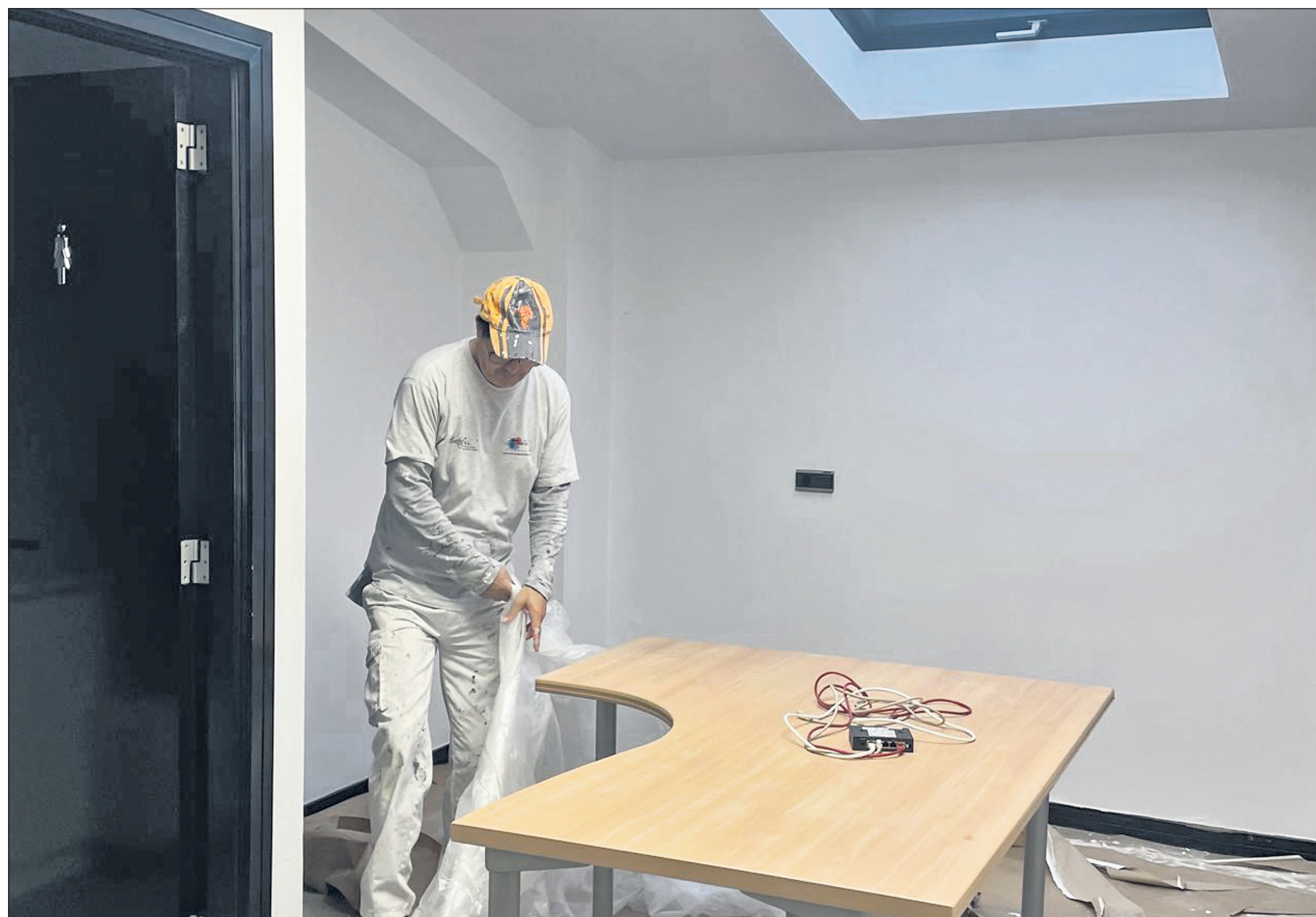
Un trabajador realizando una obra en un local de oficinas en Santander. / ALERTA
