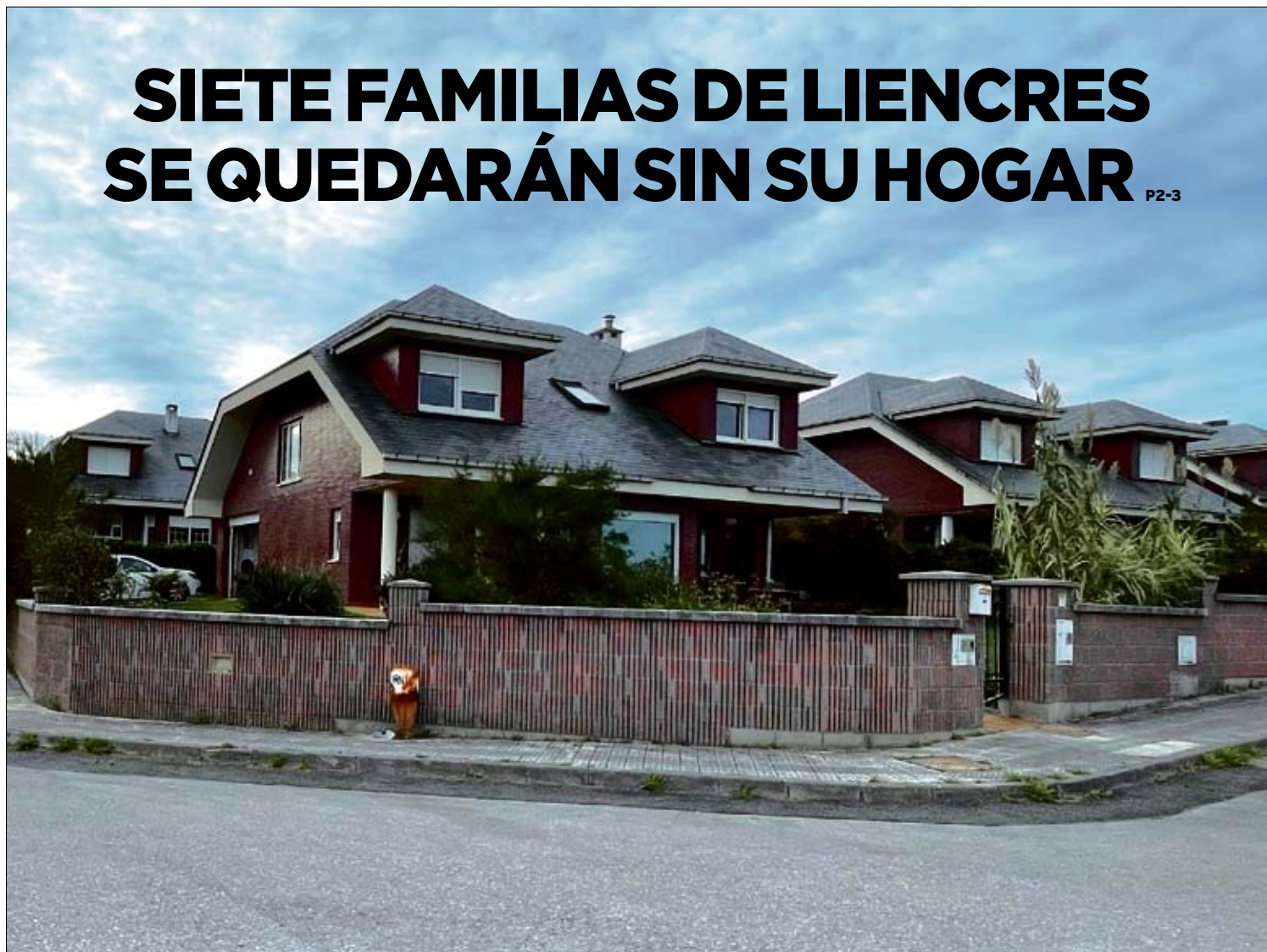
Viviendas de la urbanización 'Cerrias II' que serán derribadas el próximo dos de octubre según una notificación del alcalde de Piélagos. /M.P.
